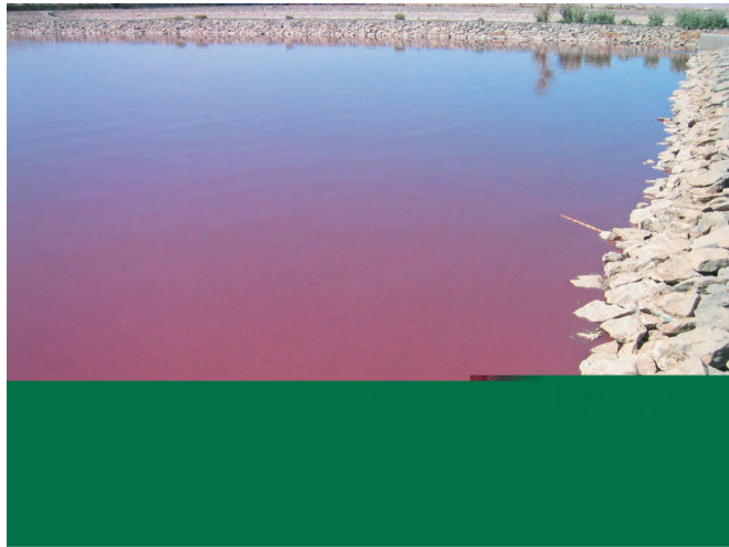
اللون الاحمر مؤشر على زيادة او نقص الحمل العضوي وفحص الـ BOD هو الذي سيحدد الحالة
